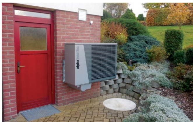
Rekonstrukce rodinného domu, východní Čechy
