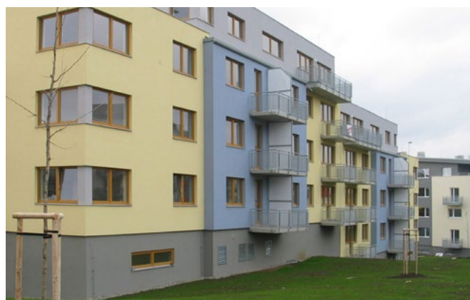
Komplex bytových domů, Praha, vnitřní systém vzduch/voda
