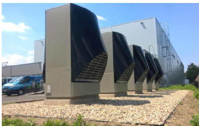
Průmyslová hala, venkovní systém vzduch/voda
