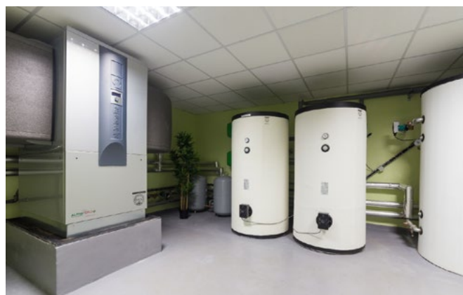
Rekonstrukce bytového domu, vnitřní systém vzduch/voda
