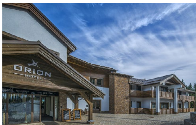
Hotel Orion, Krušné hory, vnitřní systém vzduch/voda
